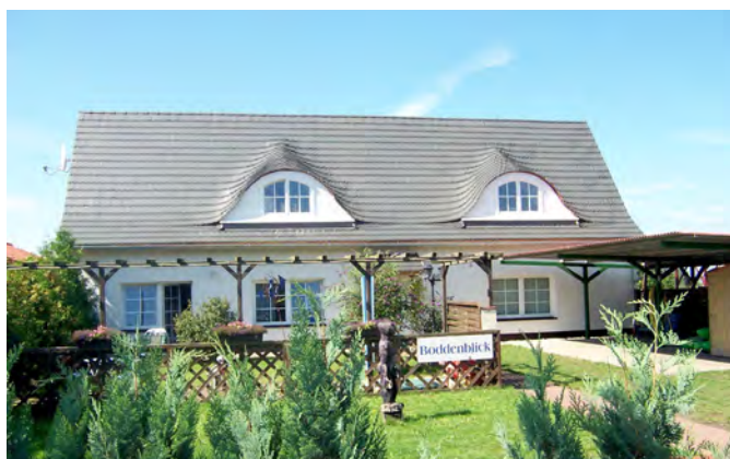
Fuhlendorf, Dorfstraße 90 (Einfamilienhaus)
